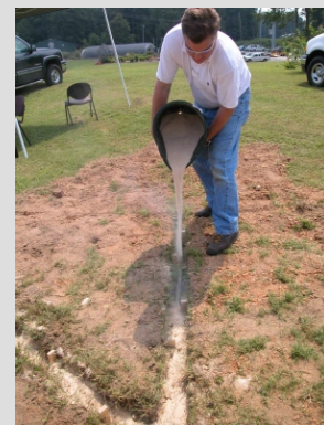
Installing Sand back fill
